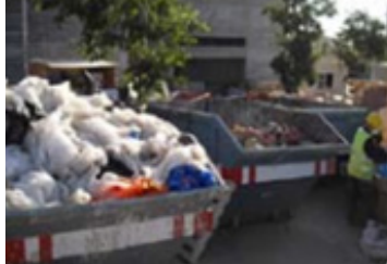
Separación de residuos en obra. Fuente: Ihobe sociedad pública de educación ambiental. Manual Ihobe para redacción e implantación de plan de gestión de residuos de construcción y demolición y buenas prácticas gremiales. 2012
